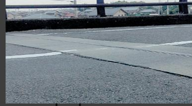
わだち掘れの発生は、車両通行時の走行不安や騒音振動による床版の劣化を助長する。
