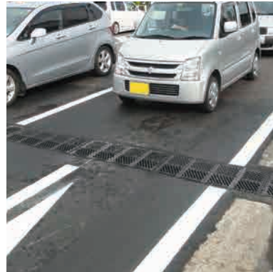
佐賀県鳥栖土木事務所(幹線道路)
