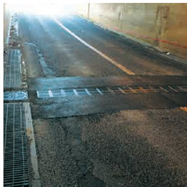
埼玉県朝霞市(アンダーパス)
