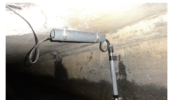
水位計設置状況
