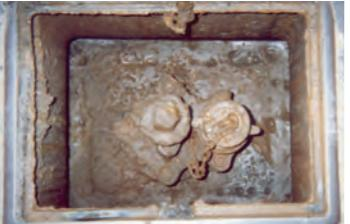
蓋表面より土砂等が流入し、弁室内に堆積した状況
